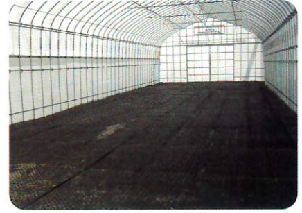
大型ビニールハウス全面養生
