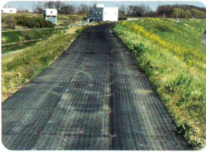
河川専用道路 重機搬入養生
