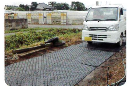
トラックの通路養生
