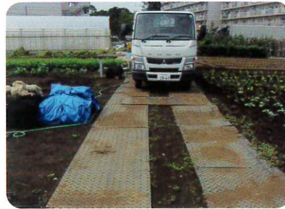
畑内路面養生
