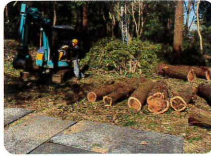
林道 足場養生
