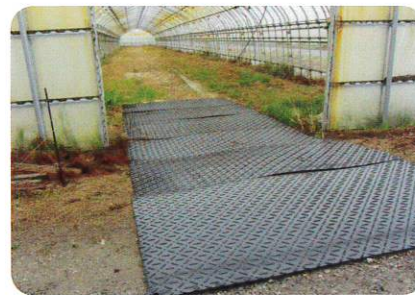
ビニールハウス出入口養生
