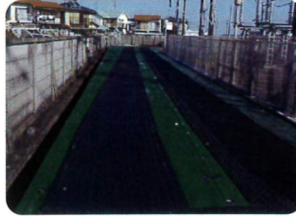
電力会社 変電所通路養生
