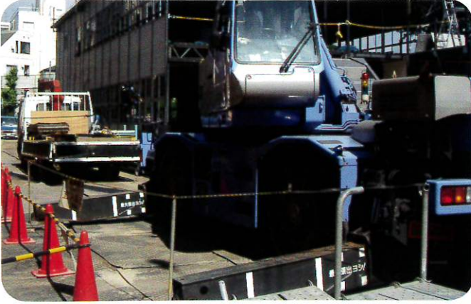
駅舎工事現場
