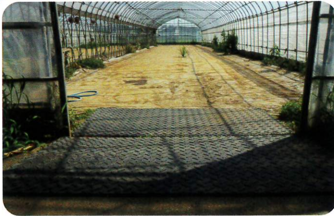
ビニールハウス入口養生
