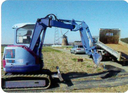
乾田内通路養生
